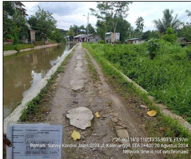
Gambar 2.28 Foto Jl. Kalimanggis (Sampel Jalan Kondisi Rusak Berat) Sumber: DPUPR Kota Magelang, 2025
